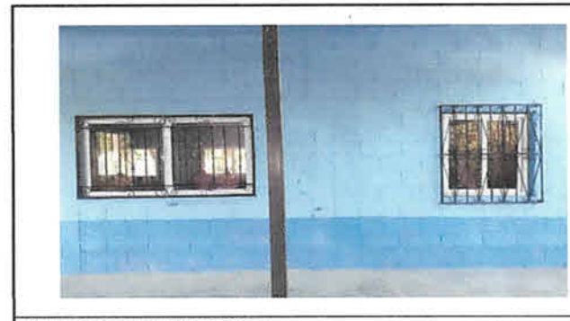
Foto 6: Colocacion de balcones
