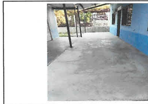
Foto 4: Piso del corredor
